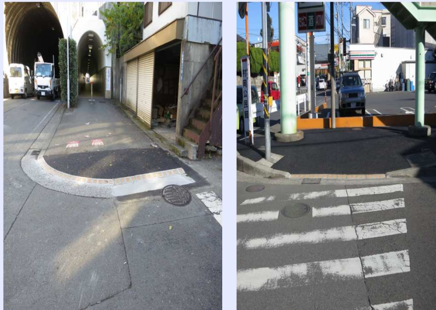
村岡トンネル西側出口・村岡歩道橋(平成24年度)
