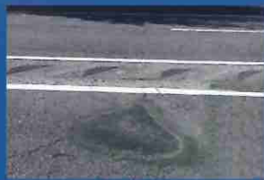
穴ぼこを補修し、安全を確保！
